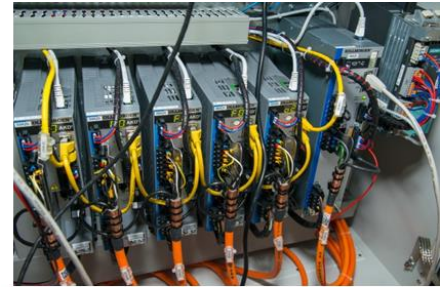
L'unità di alimentazione AKD-C (a destra) si occupa dell'alimentazione dei servoazionamenti decentralizzati. ME 2 utilizza inoltre i convertitori nell'armadio di distribuzione della serie AKD per gestire altri azionamenti oltre alla tavola rotante.
